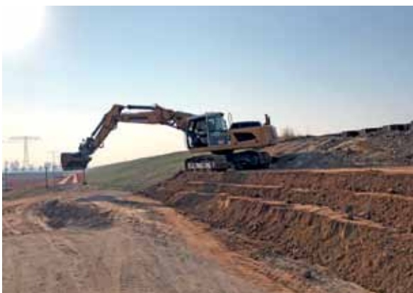
Digitale Maschinensteuerung beim Deichbau in Zwethau
